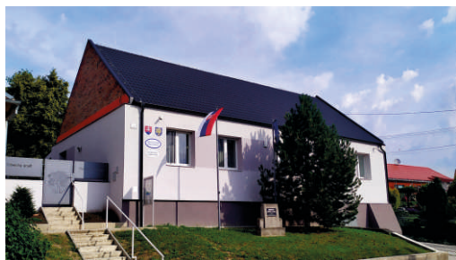
Obnova budovy Obecného úradu
