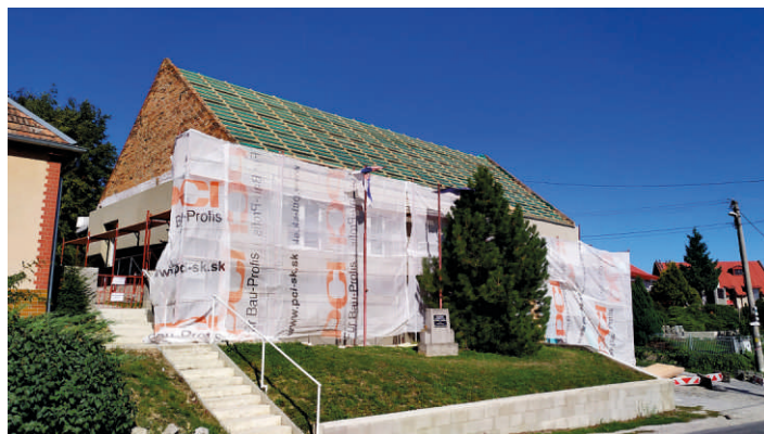
Obecný úrad počas rekonštrukcie
