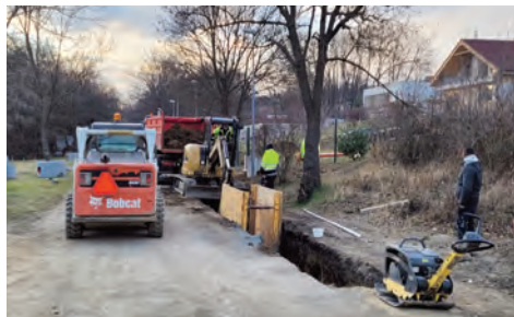
Rozšírenie kanalizácie (IBV NIVA - Stará cesta)
